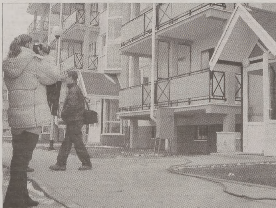
WTBS oddało do użytku kolejne dwa budynki mieszkalne przy ul. Przemysłowej w Wejherowie.
