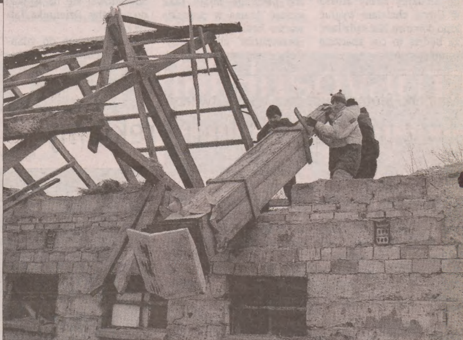
Strażacy z OSP i sąsiedzi pomagali w rozbiórce dachu.
