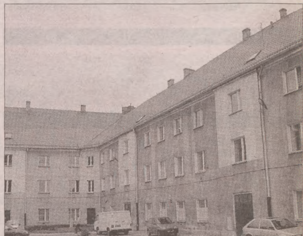
Obecny wygląd budynku, w którym mieści się Zespół Szkół Zawodowych.
