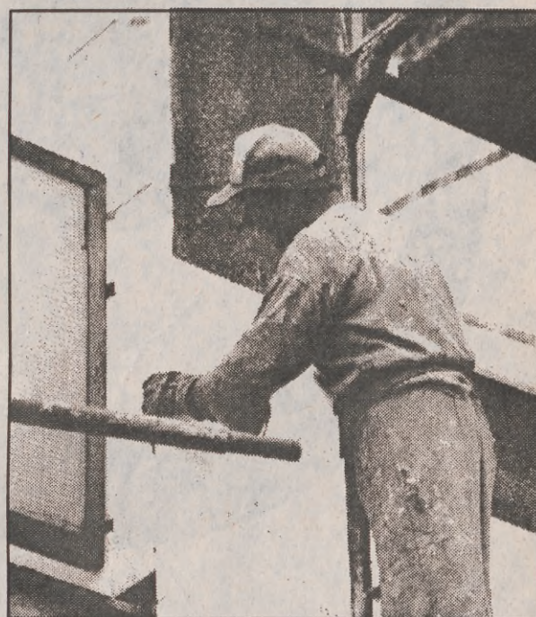
Także spółdzielnie z Koszalina starają się racjonalizować zużywaną ciepło. Na zdjęciach: prace przy docieplaniu bloku przy ulicy Rzemieślniczej należącej do Koszalińskiej Spółdzielni Mieszkaniowej „Na Skarpie”. (jas)
