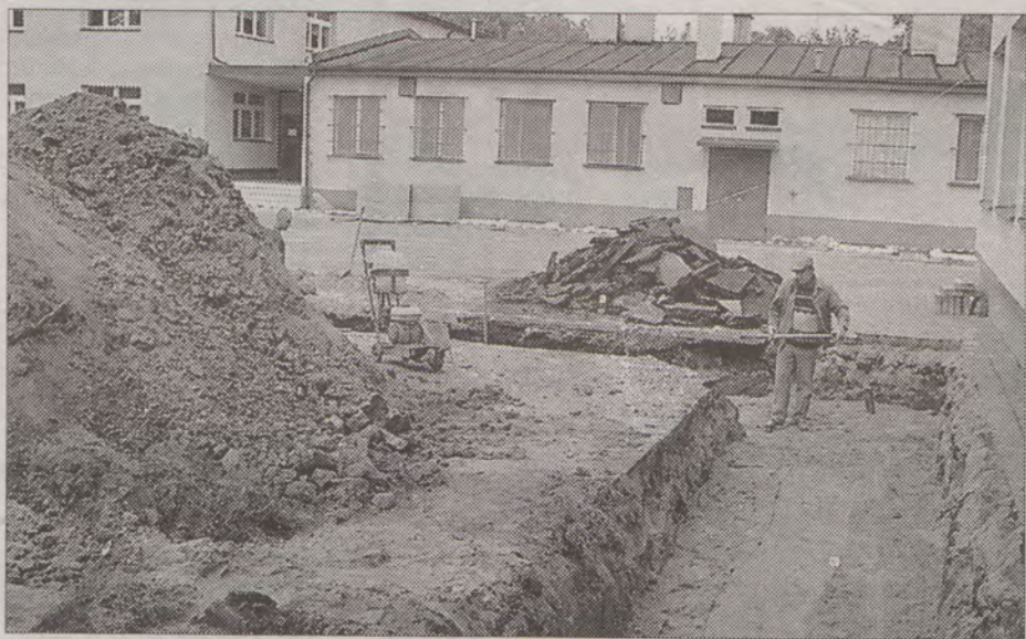
Prace budowlane w szkole imienia Lotników Polskich ruszyły pełną parą. Fot. Elżbieta Chylińska
