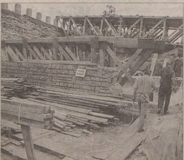
Renowacja bastionu potrwa do końca roku.
