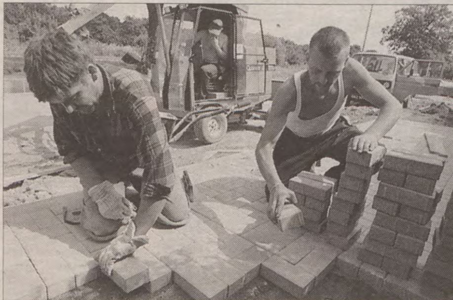
Prace drogowe na Morenie i remonty ulic nie odciążą zakorkowanego Gdańska.
