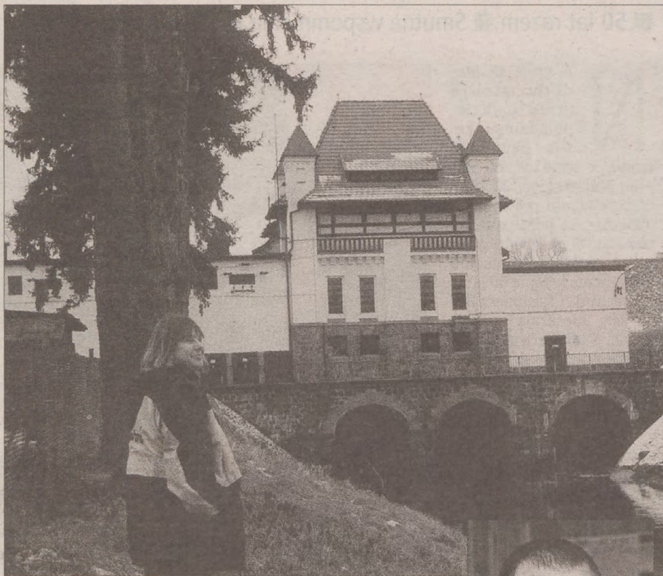
Elektrownia wodna w Straszynie.
