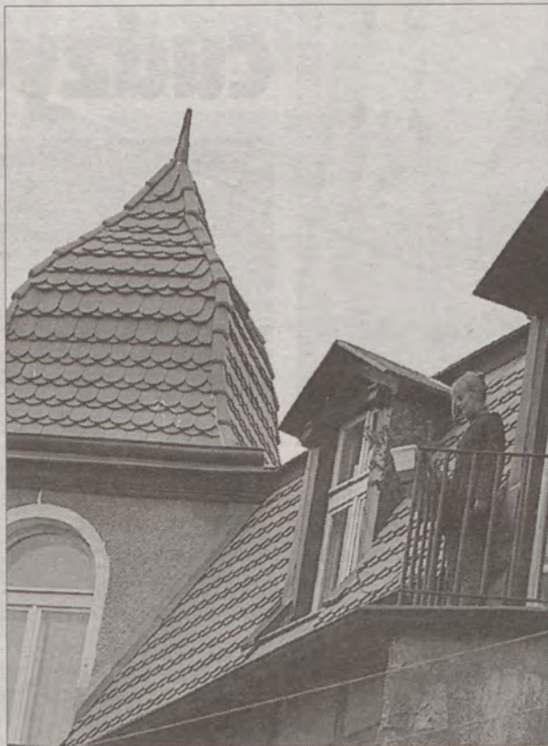
Wyremontowano dach kamienicy przy ul. Leśnej 3.
