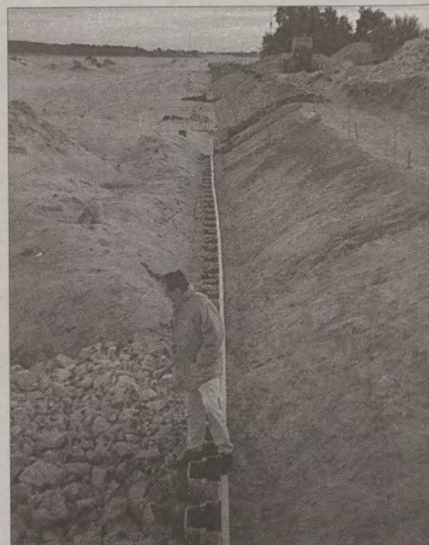
W Gdańsku Górkach Zachodnich trwa drugi etap budowy wejścia portowego.
