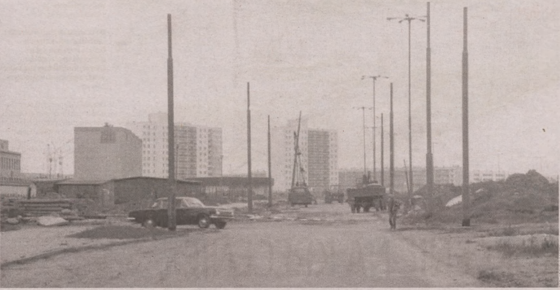
Budowa infrastruktury trolejbusowej na os. Budowniczych Polski Ludowej (Niepodległości), ul. Wielkiego Proletaryatu (dziś 11 Listopada), rok 1985
