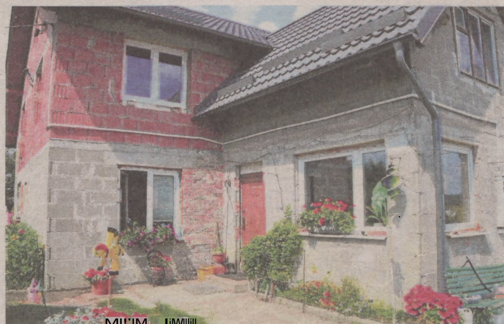
Odremontowany dom rodziny Błaszkwskich. Jeszcze dużo pracy przed nimi...
