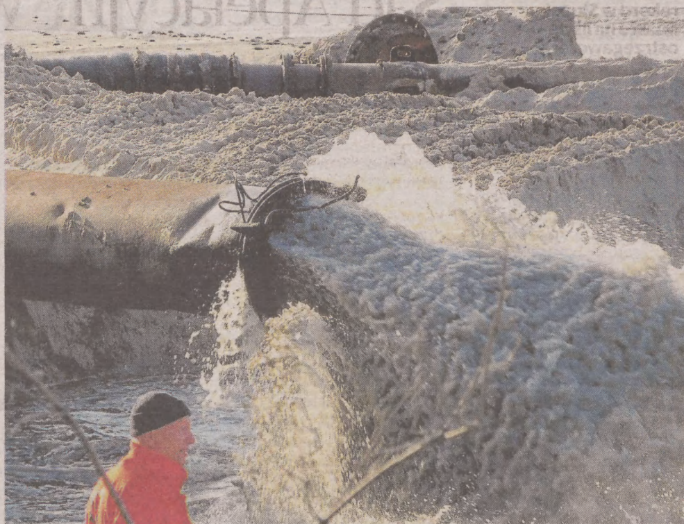
Rekulacja plaży w Ustce. Z osadników oraz toru podejściowego do portu pobierany jest piach i żwir. Pogłębiarka zasysa go, a następnie wpompowuje na plażę dzięki specjalnym rurom
