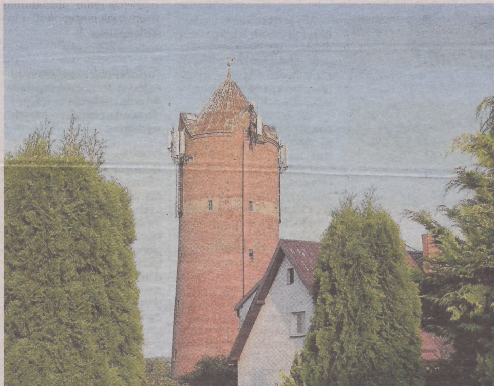
Na dawnej wieży ciśnieniowej jest już zamontowanych 13 nadajników różnych operatorów. Kolejny chce na wieży zamontować trzy następne urządzenia
