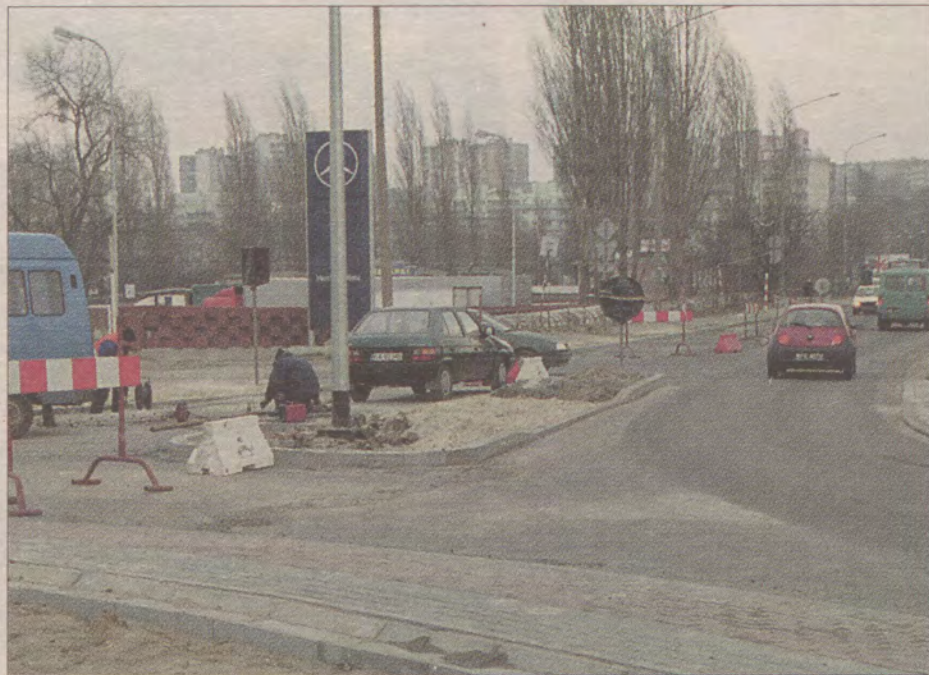
Zdaniem wielu obserwatorów prace na rondzie posuwają się zbyt wolno
