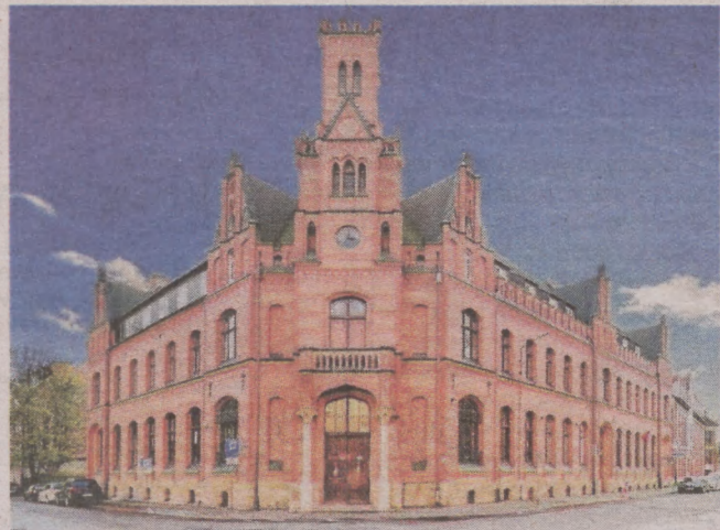
Dawna siedziba Telekomunikacji Polskiej, a dziś Orange idzie pod młotek. Mowa o pięciu budynkach w kompleksie
