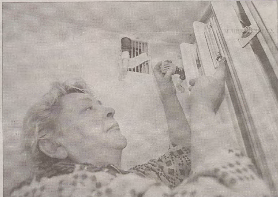
Kaloryfer w łazience umieszczono 20 cm od wywietrznika.
