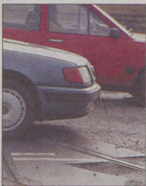
Remontowany węzeł Hucisko jest pełen usterek.
