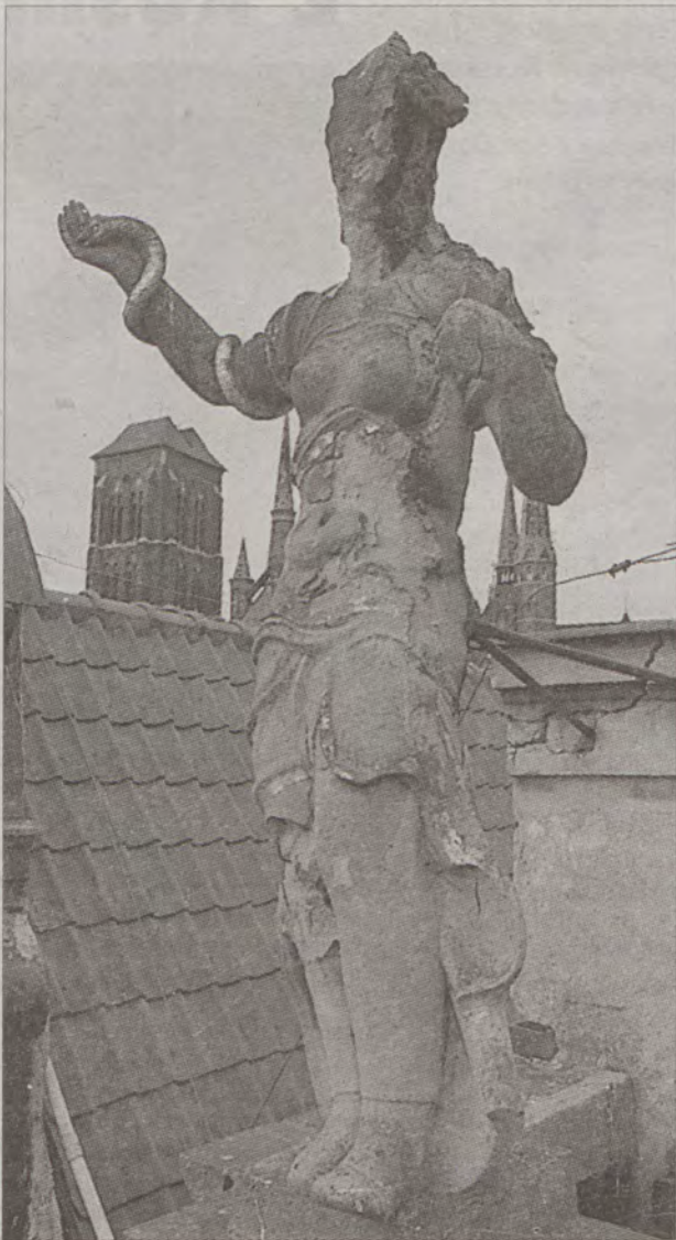
Ze zniszczonej elewacji Złotej Kamieniczki odpadają całe fragmenty posłoczonych ornamentów i rzeźb.
