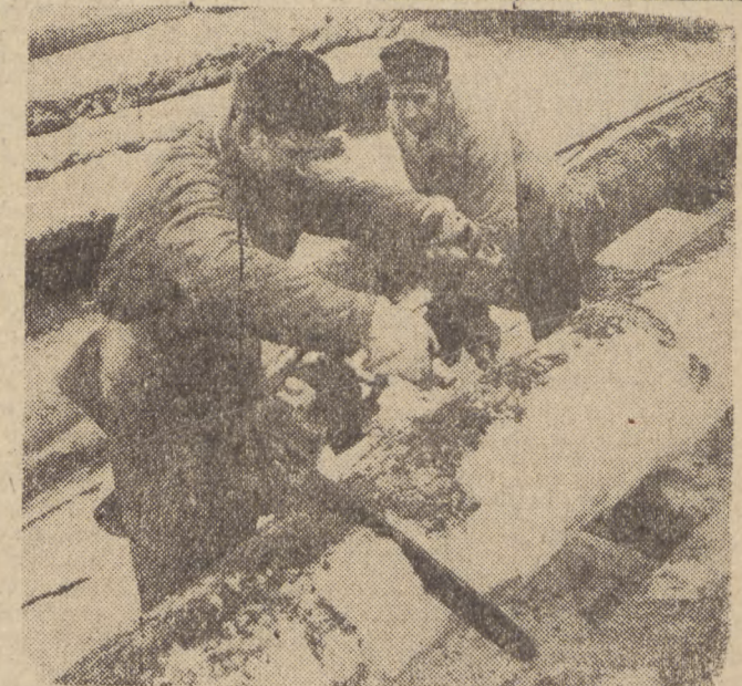
Trudna jest praca na mrozie, przy ciężkich, obsypanych śniegiem dachach. Talerz gorącej zupy jest w tartaku niecierpliwie oczekiwany. (Fot. J. Piątkowski)
