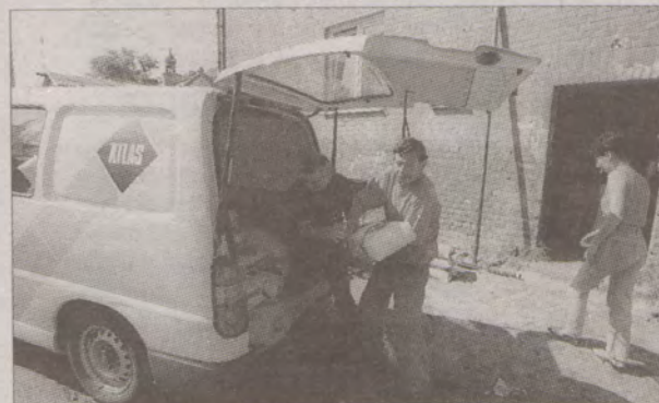
Do popowodziowych mieszkań trafiają materiały budowlane.
