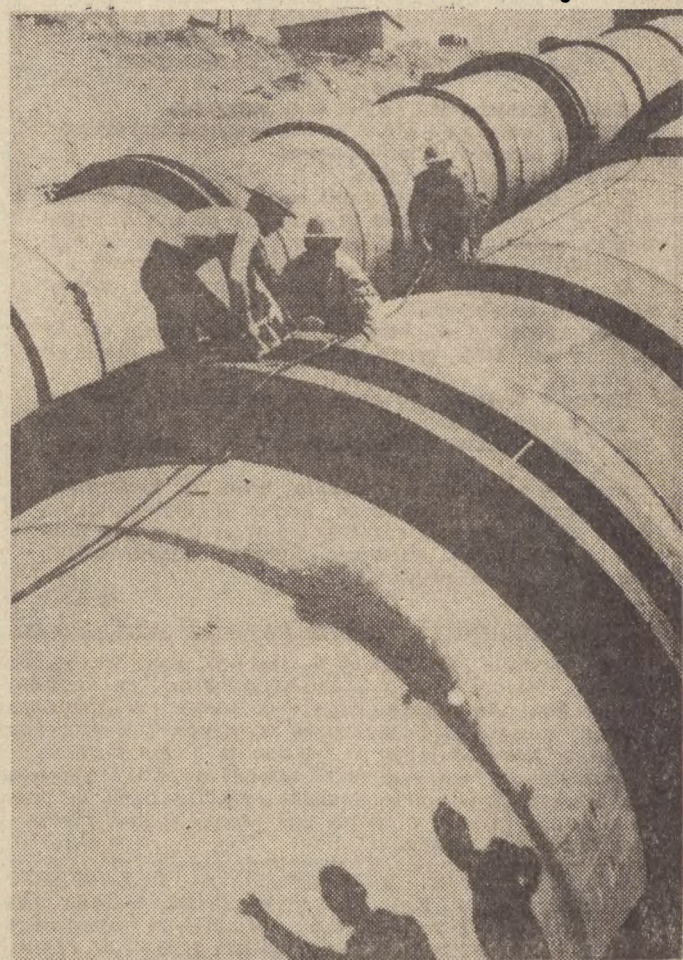
17 UDOWA elektrowni wodnej w Żydowie (pow. stawieński) weszła w ostatnią fazę. W końcu lipca nastąpi odanie pierwszego generatora o mocy 50 megawatów, a to koniec września ruszą dwa następne po 50 MW. Wykonano już całkowicie kanał przepływowy oraz 3 „nitki” rurowe. Trwa montaż pierwszego generatora.
