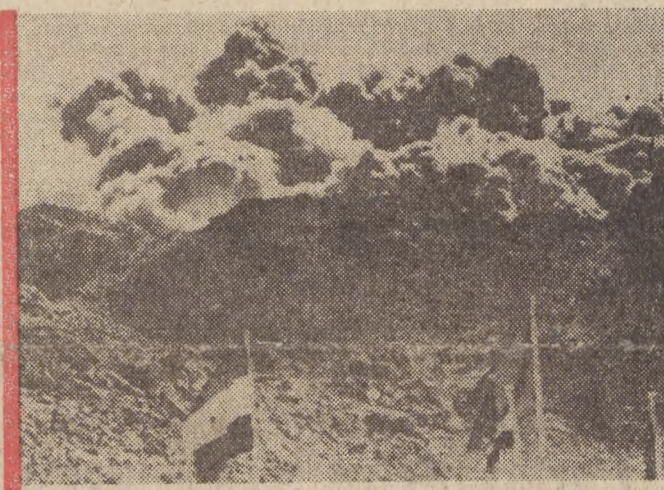
Na zdjęciu: eksplozja pierwszych ładunków dynamitu — zdjęcie archiwalne sprzed 11 lat przedstawia rozpoczęcie prac na budowie wielkiej tamy asuańskiej. CAF — UPI
