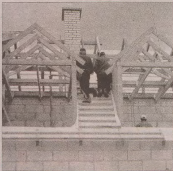
Obecnie na nowej szkole w Bytoni powstaje dach.
