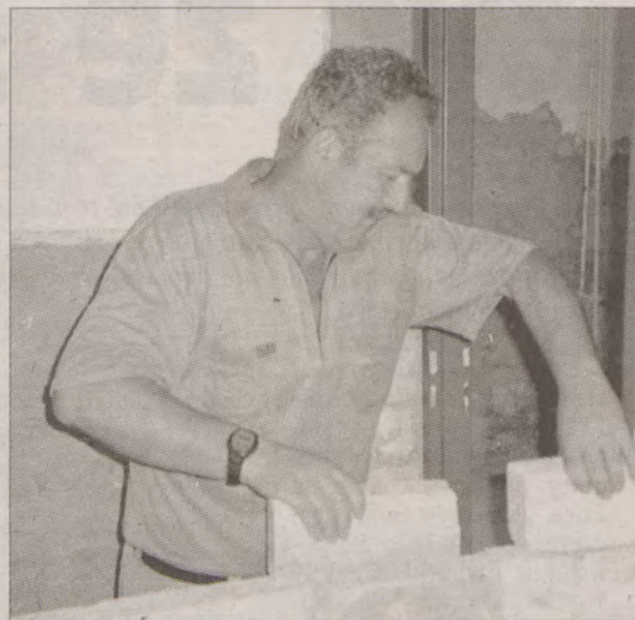
Zenon Wolszlegier podczas budowy kabin toaletowych w szkole w Osieku.
