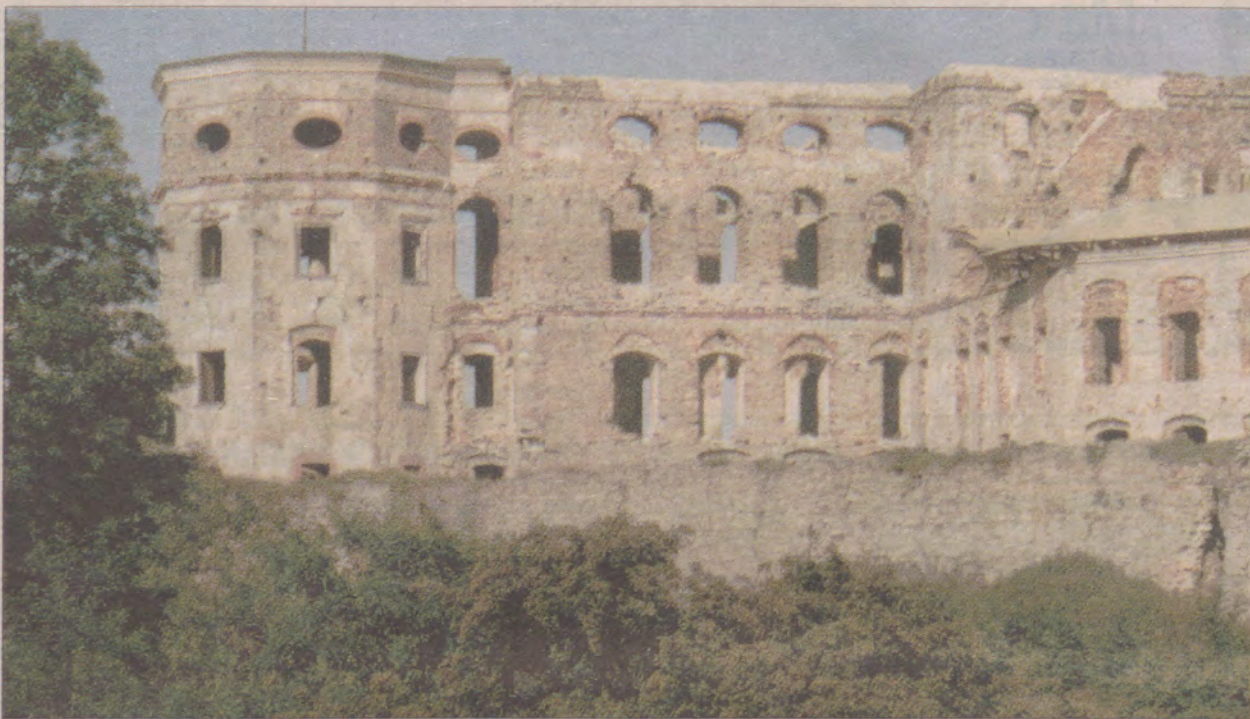
Dawny pałac forteca miał kilka kondygnacji. Rolę sufitu jednej z sal, w wieży po lewej stronie, spełniało akwarium.
