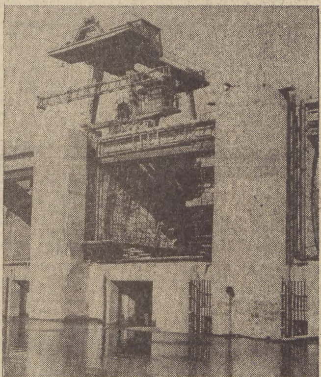
W Głębinowie koło Nysy powstaje wielki zbiornik wodny, który uchroni dolinę Nysy Kłodzkiej przed licznymi powodziami, stworzy znacznie lepsze warunki żeglugowe oraz zaopatrzy region Śląska Opolskiego w dodatkowe ilości energii elektrycznej. Na zdjęciu: fragment budowy. CAF — Okoński
