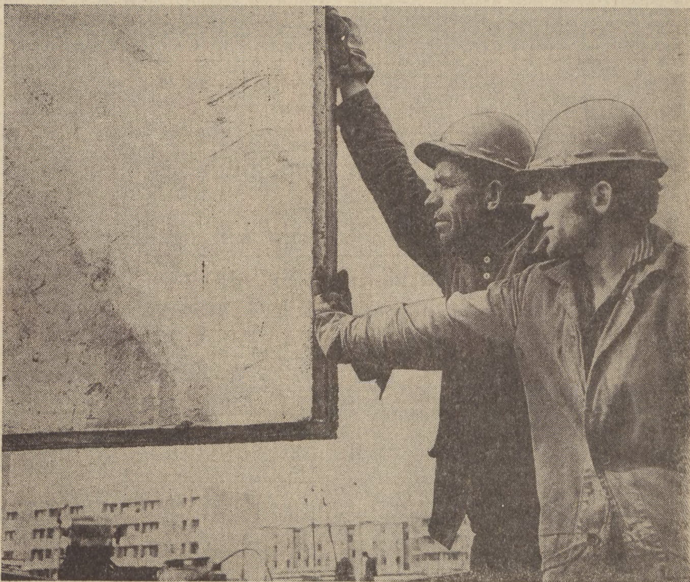
Józef MICIELSKI i Władysław KOWAL, betoniarze Poligonowego Zakładu Prefabrykacji w Koszalinie.
