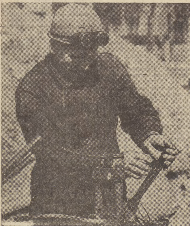
Józef Włoch, montażysta c.o. KPiB, odcinek Kołobrzeg. Fot. J. Patan
