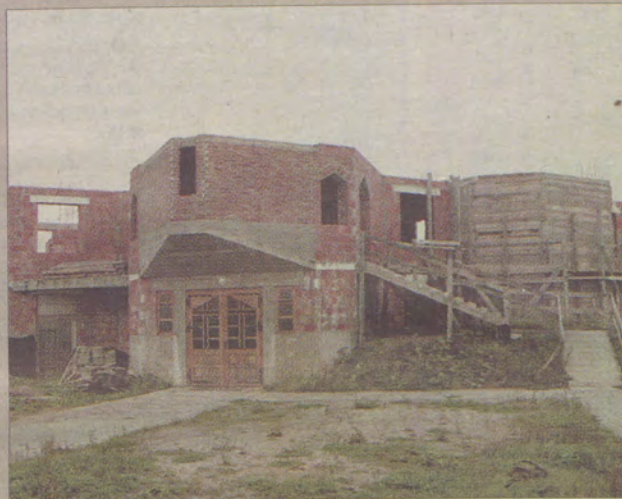
Świątynia w budowie.
