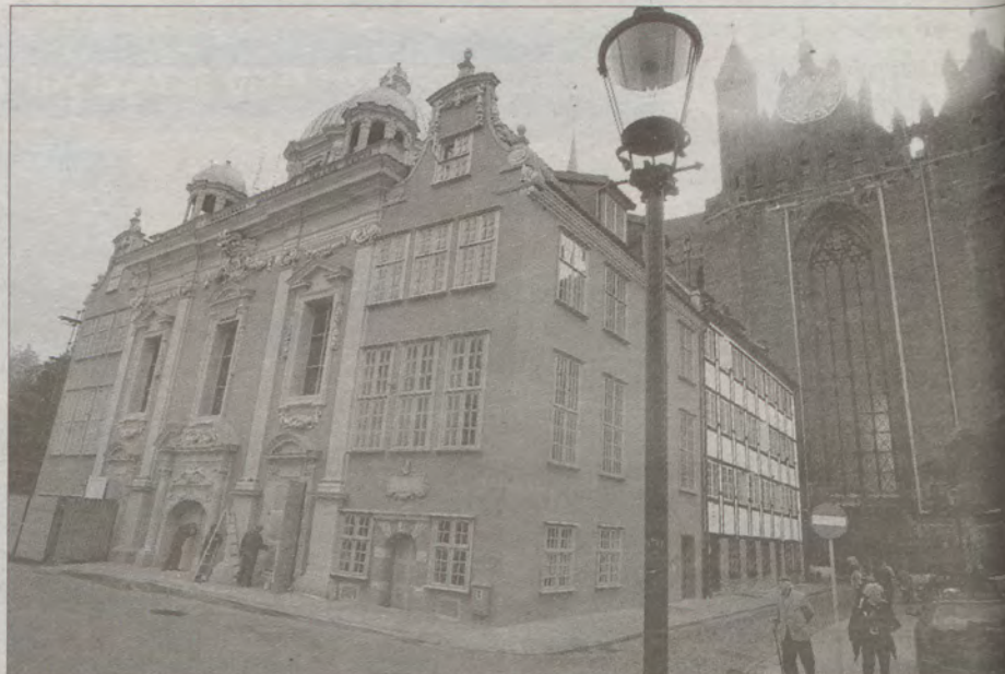
Wczoraj zdemontowano rusztowania okalające kopułę Kaplicy Królewskiej w Gdańsku, której restaurację zakończyli konserwatorzy.
