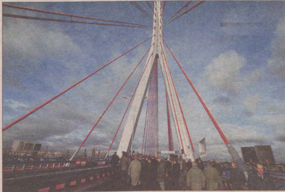
Gdański most podwieszony posiada przęsło mające rozpiętość 230 m. Fot. Robert Kwiatek
