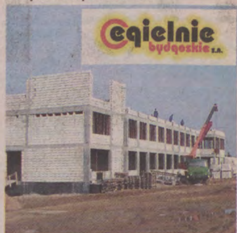
budowa gimnazjum w Sierakowicach wykonywana w technologii silikatu.
