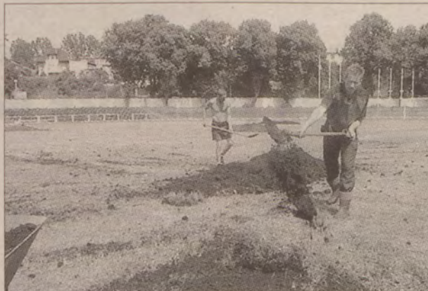
Na stadionie Chojniczanki trwają prace remontowe.
