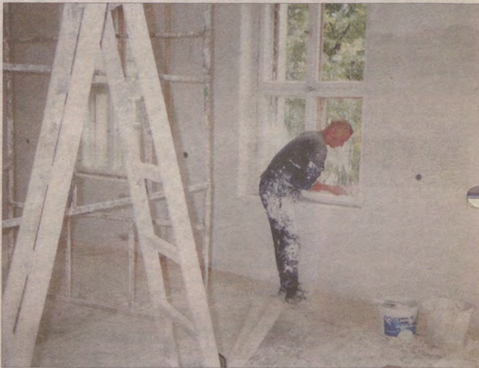
Prace wykończeniowe w stołówce wykonuje Krzysztof Kurkowski.
