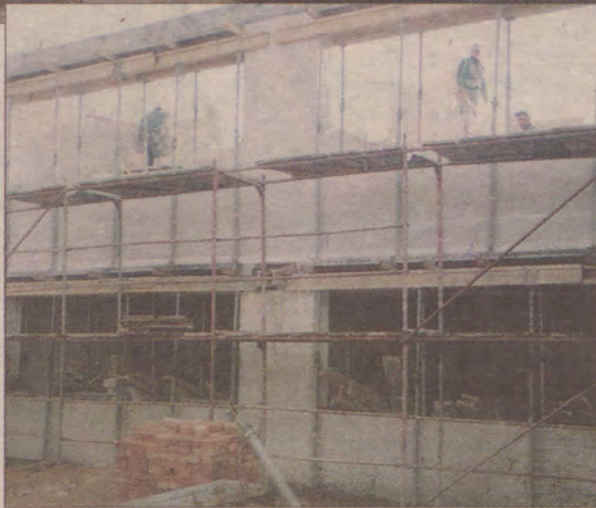
(B.W.) Budowana hala produkcyjna.
