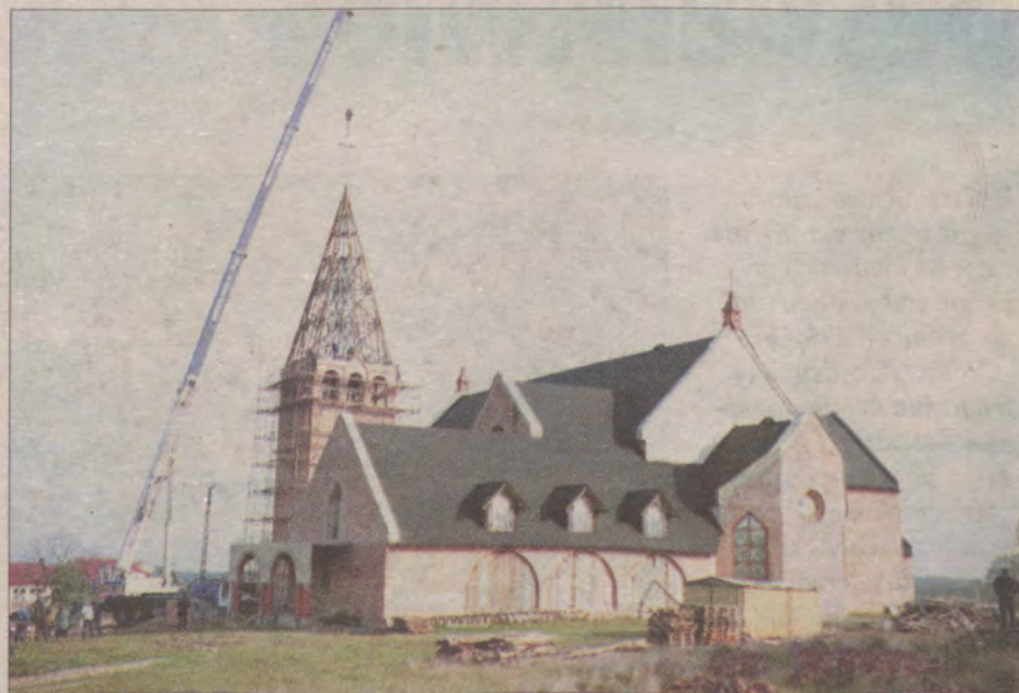
Iglicę na wieży kościoła w Bojanie zainstalowano przy pomocy ogromnego dźwigu.
