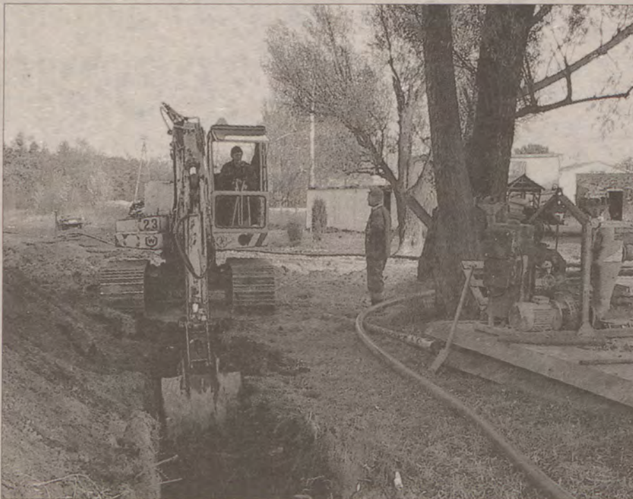
Prace przy budowie kanalizacji w Czarniżu. Na zdjęciu Marek Murawski, operator koparki. Obok stoi Jan Rogala.
