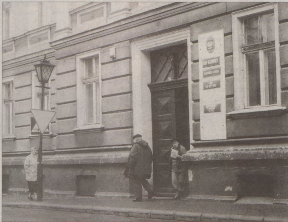
Sprawy rozpatrywane dotychczas przed kolegium do spraw wykroczeń trafiają teraz do sądu grodzkiego. Na zdjęciu Sąd Rejonowy w Chojnicach.
