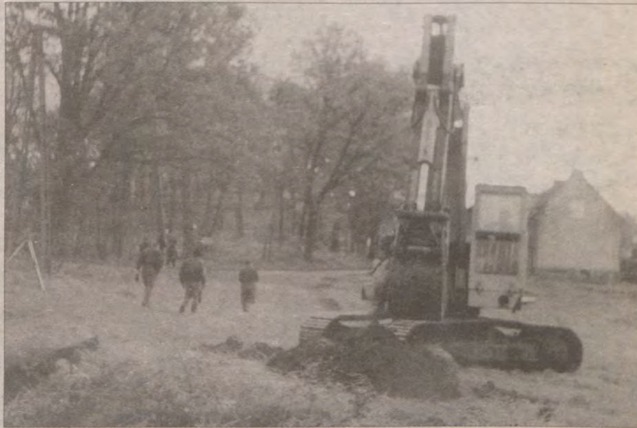
Prace przy kanalizacji w miejscowości Jarcewo.
