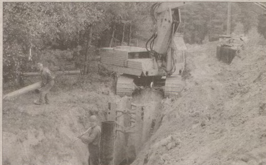
Budowa kanalizacji w Rytle.
