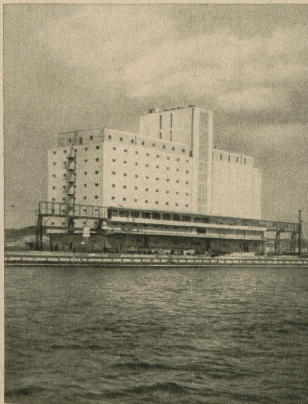
Elewator zbożowy w Gdyni
