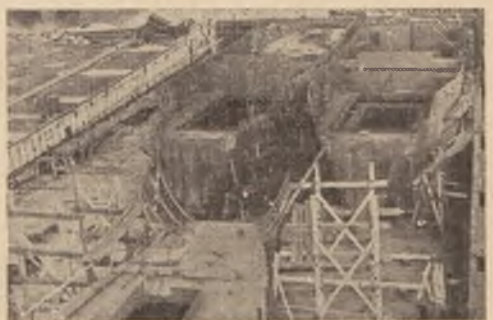
Rośnie nasza flota. Oto kadłuby trzech z serii pięciu drobnicowców motorowych po 650 DWT, budowanych na jednej z polskich stoczni. Jak widać, prace są już znacznie zaawansowane.
