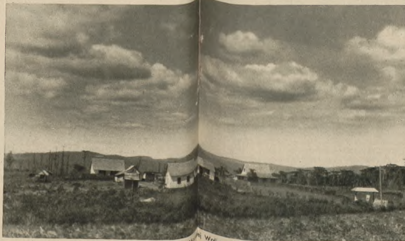
Budynki w Woli w Paranie
