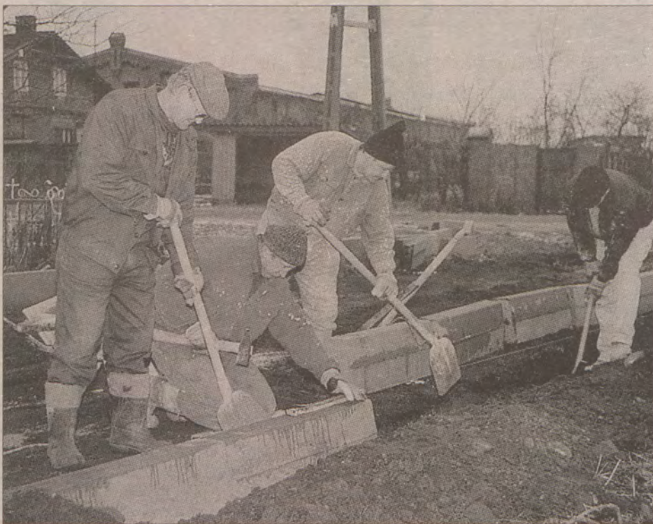
We wsi budowana jest obecnie droga.
