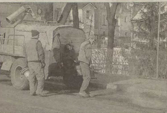
Pracownicy firmy Bazalt podczas prac remontowych. Fot. Piotr Szymański
