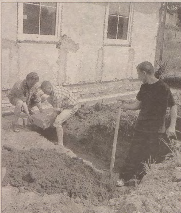
Piotr Stec (z prawej) wraz z braćmi, Marcinem i Marciem, podczas budowy tarasu.
