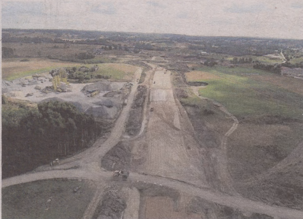
Tak wygląda budowana s6 między Bożymy Wielkim a Trójmiastem. To trasa kaszubska, która zostanie oddana jeszcze w tym roku. Skróci to podróż ze Słupska do Gdańska
