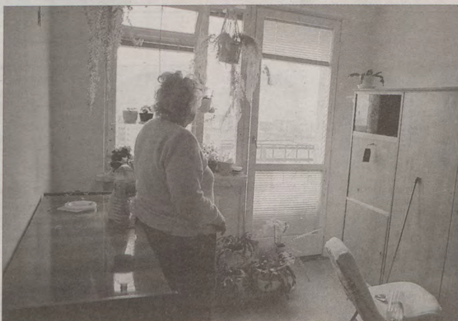
Mieszkanie Wandy Brzezińskiej zostało zalane w wyniku akcji gaśniczej.
