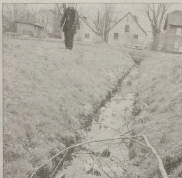
Ścieki z Łęgowa trafiają do kanalizacji burzowej i rowu, m.in. tego przy drodze krajowej nr 1.
