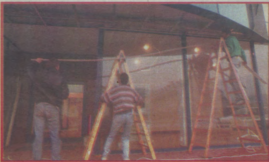
Prace przy wejściu do fabryki
