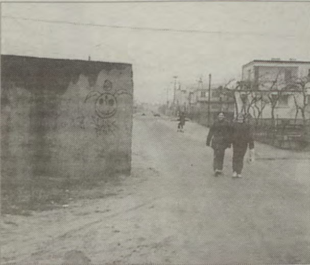
Betonowa przeszkoda na drodze.
