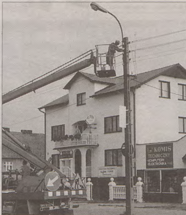
Wymiana oświetlenia przy ul. Dąbrowskiego
