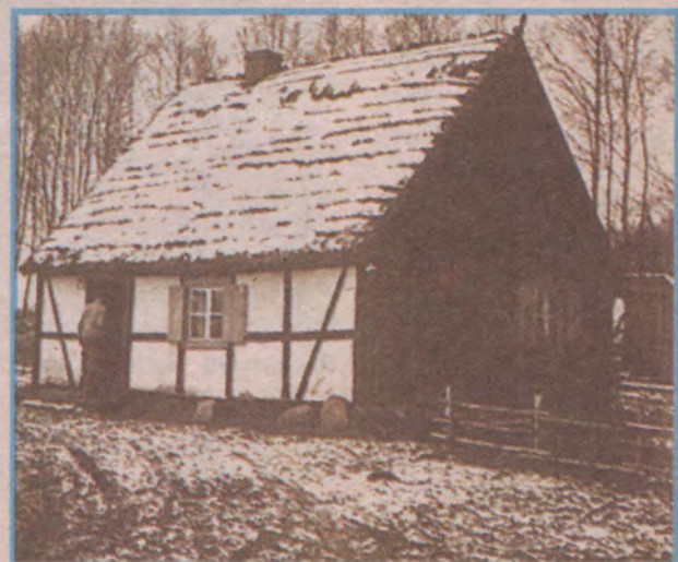
Stara chęć o konstrukcji szachulcowej w Łączyńskiej Hucie.
